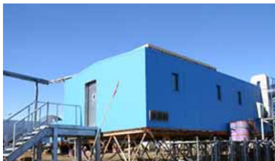
8次隊建設の観測棟（新観測棟であったことから、略称はシンカン）
